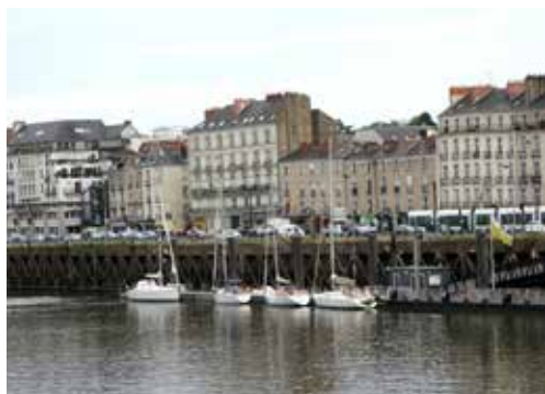
Ponton Anne de Bretagne at Nantes
